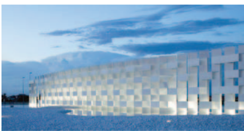
Spettacolare. Casalgrande padana, opera architettonica del maestro Kengo Kuma, tridimensionale filtrante, flessibile in grès "eterno"
